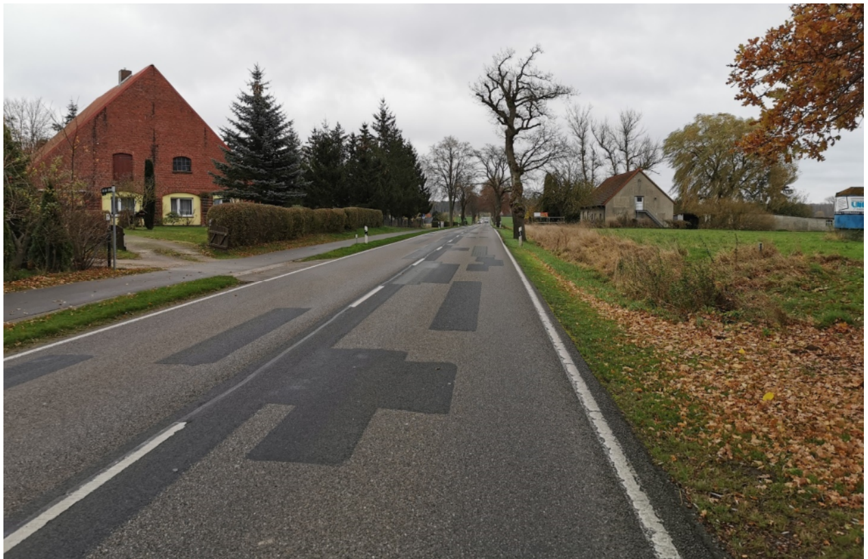
Foto 7: Die Fahrbahn zeigt Kornverluste und unterschiedliche Flickungen mit Oberflächenbehandlungen.
