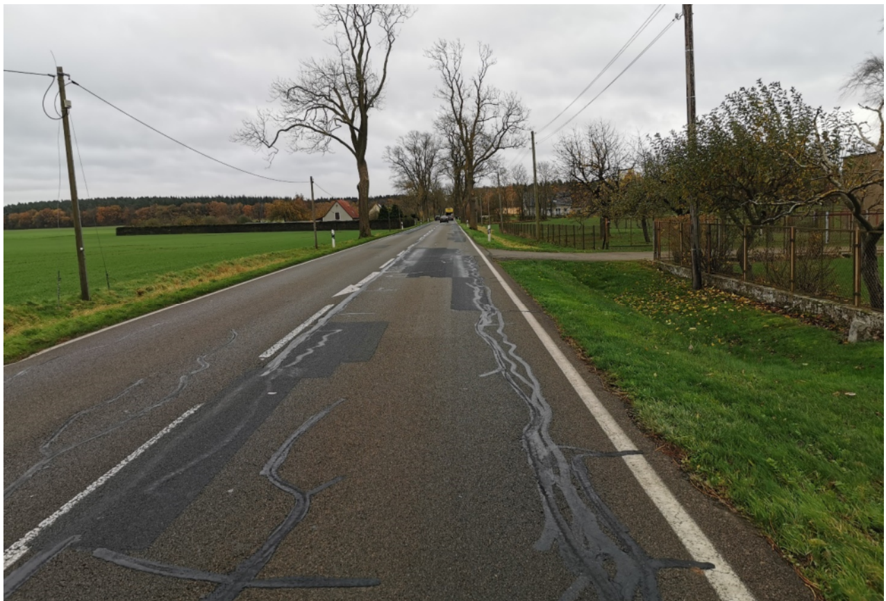
Foto 4: Die Loitzer Straße in Poggendorf hat im Bereich der rechten Rollspur mehrere Längsrisse.
