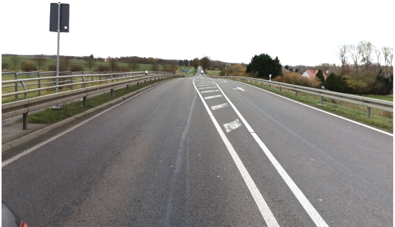
Foto 13: Blick in Richtung Grimmen. Es sind leichte Ausmagerungen in der Deckschicht erkennbar.
