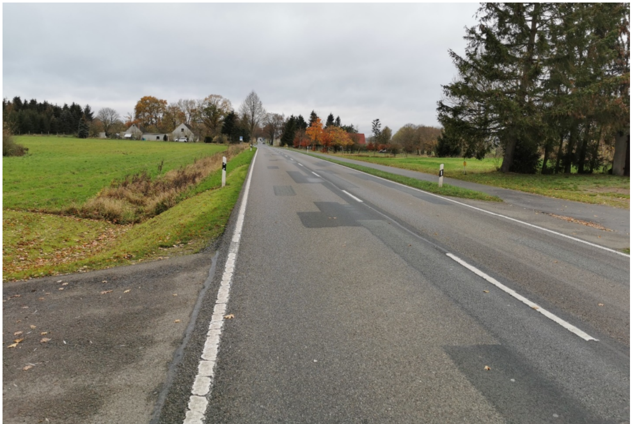
Foto 8: Die Mittelnaht ist in Teilbereichen offenporig, so daß Wasser eindringen kann.
