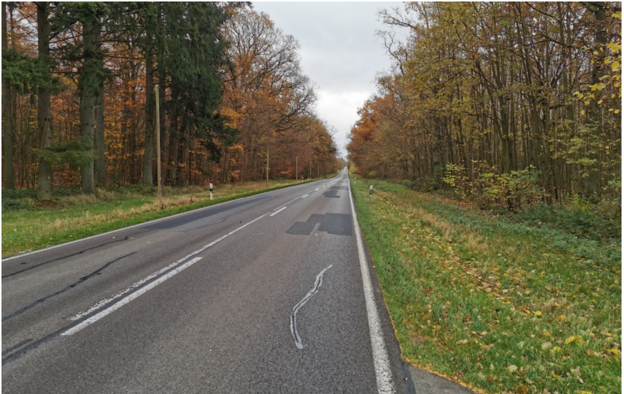
Foto 1: Blick in Richtung Amtsgrenze (Loitz). Hier sind in beiden Fahrstreifen Längsrisse und Flickungen erkennbar.
