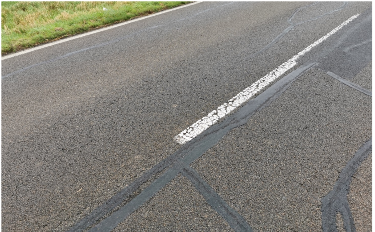
Foto 5: Die Fahrbahn ist hier stark ausgemagert mit Kornausbrüchen in der Deckschicht und in der Mittelnaht.
