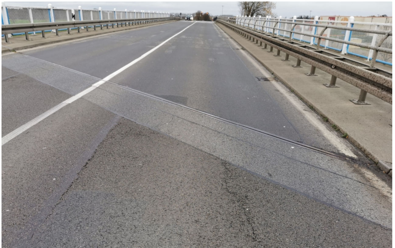
Foto 12: Auf der nördlichen Brückenseite wurden unterschiedliche Risse im Bereich der ÜKO festgestellt.
