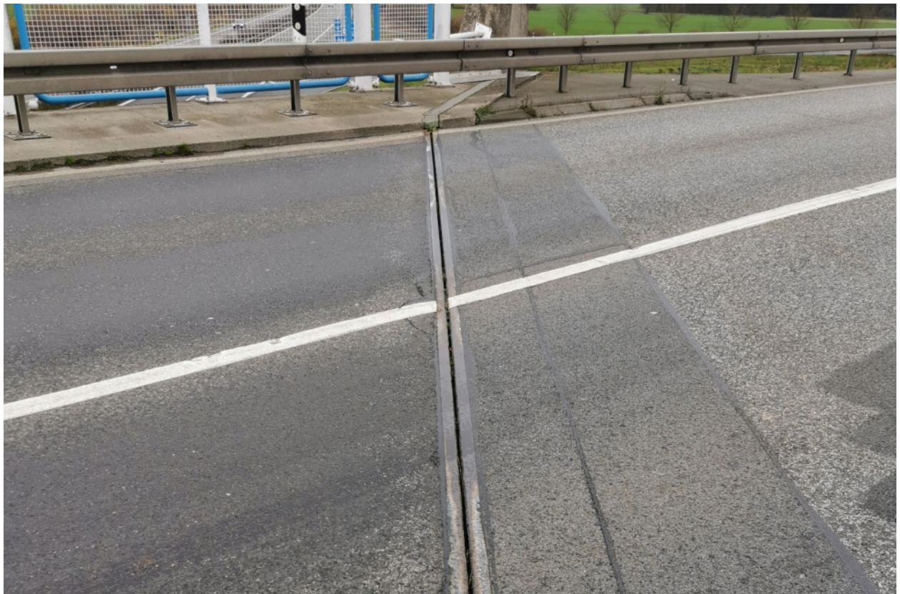
Foto 10: Im Bereich der ÜKO sind Risse vorhanden.
