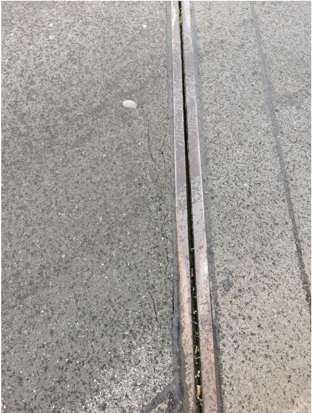
Foto 11: Im Bereich der Übergangskonstruktion auf der südlichen Brückenseite sind Risse vorhanden.
