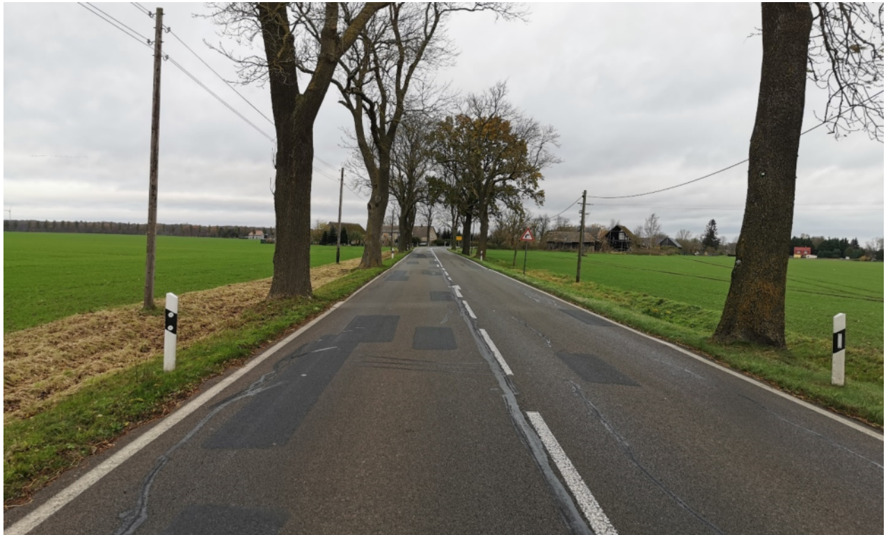
Foto 3: Blick in Richtung Ortseingang Poggendorf. Die Deckschicht ist hier ausgemagert mit leichtem Kornverlust, Flickungen und Längsrissen.
